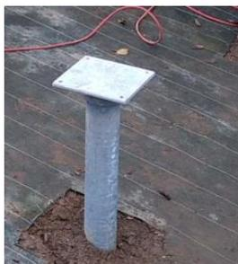
Pour mettre en place la structure bois, on utilise des platines de tête (carrées 300x300 mm, galvanisées de 10 mm d'épais, soudées sur les pieux une fois que ceux-ci sont recépés au laser).
