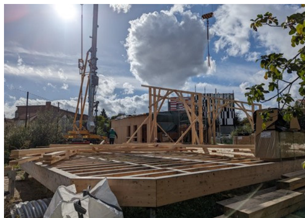
Montage du portique (Source : EODD)
