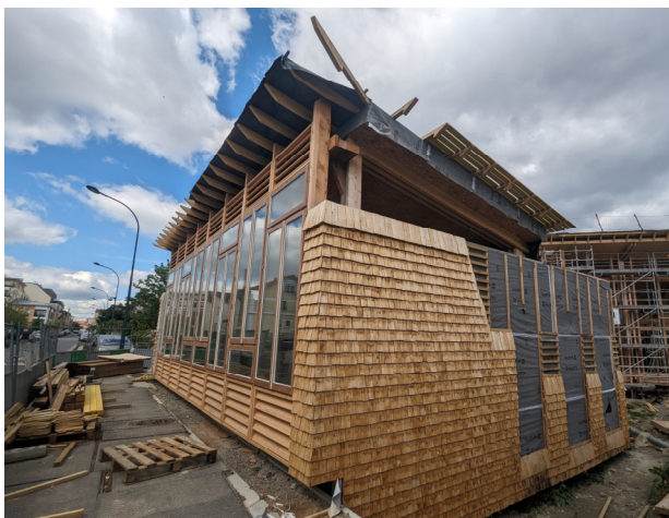
Pose des tavaillons (Source : EODD)
