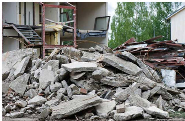
Illustration - Bâtiment conçu pour résister à un vent moyen, après sa rencontre avec un vent fort mais pas exceptionnel.
